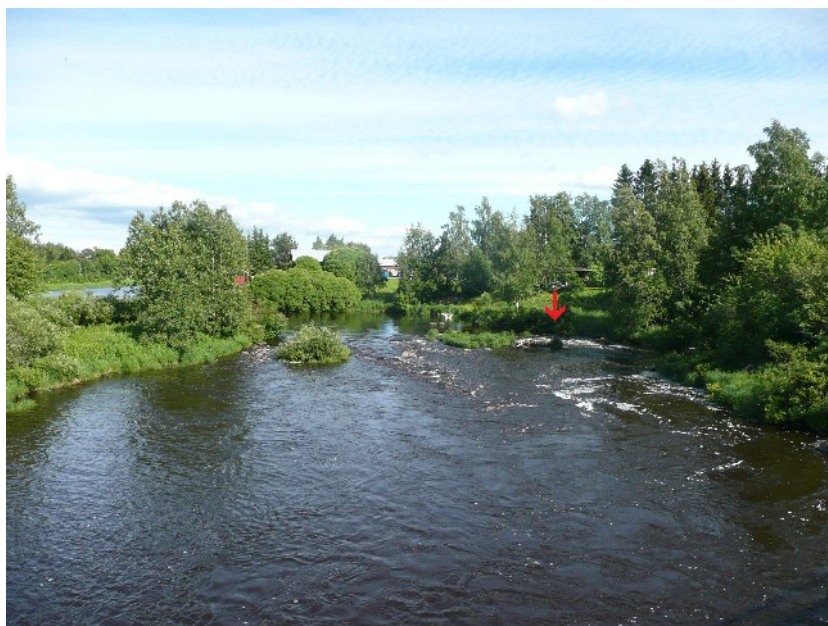
Kuva 20. Entinen padon kohta joen etelärannan ja joessa sijaitsevan saaren välissä. Kuva lännestä Myllykoskensillalta. Osittain säilyneitä padon rakenteita nuolen osoittamalla kohdalla.
