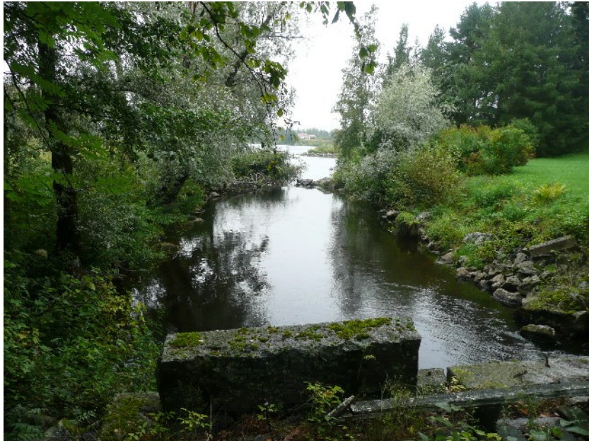
Kuva 25. Myllynuomaa ja pato t. ränni myllynpaikasta pohjoiseen.
